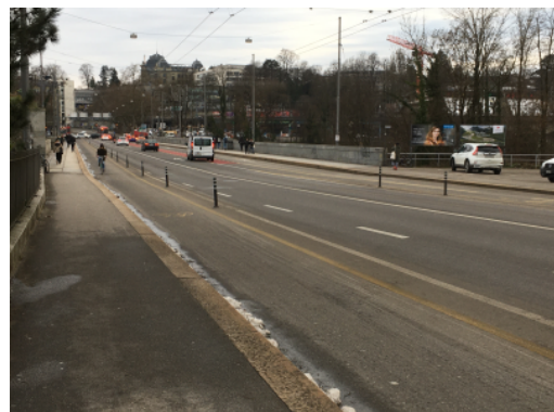
Radstreifen mit Pfosten auf der Lorrainebrücke, Bern
