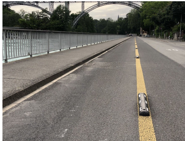
Radwegtrennelemente zur zusätzlichen Sicherung des Radstreifens in der Matte, Bern
