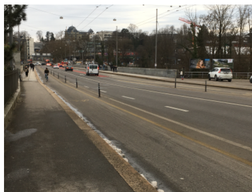
Radstreifen mit Pfosten auf der Lorrainebrücke, Bern
