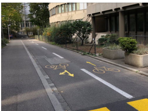
Piste cyclable bidirectionnelle dans une rue fermée au trafic motorisé à Bâle
