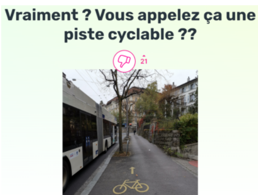
Exemple d'un point problématique identifié à Lausanne. Source: Bikeable
