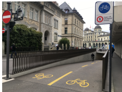
Velotunnel am Bahnhof Winterthur
