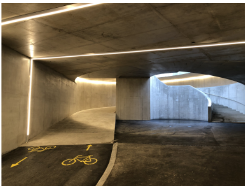
Unterführung am Bahnhof Prilly-Malley
