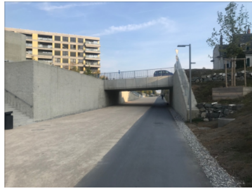
Unterführung auf der «voie verte» in Genf
