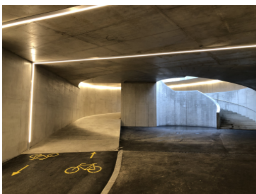
Passage inférieur à la gare de Prilly-Malley
