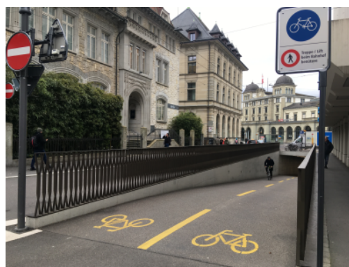
Passage inférieur à la gare de Winterthur
