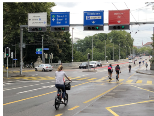
Separate Ampel für die Velospur auf der Lorrainebrücke, Bern
