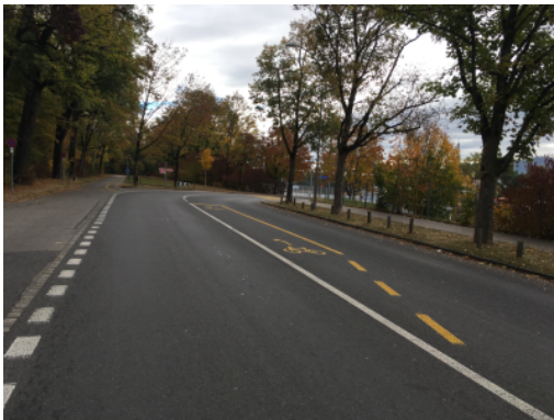
Mittelstreifen zum Linksabbiegen in der Murtenstrasse, Bern
