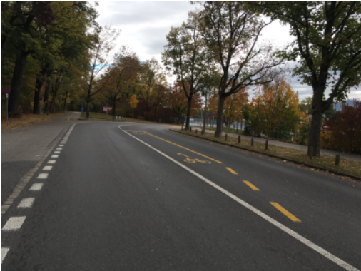
Mittelstreifen zum Linksabbiegen in der Murtenstrasse, Bern
