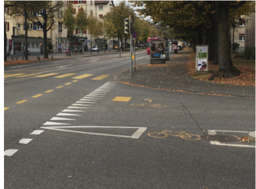
Tourne-à-gauche indirect de la Schlosstrasse à la Huberstrasse à Berne
