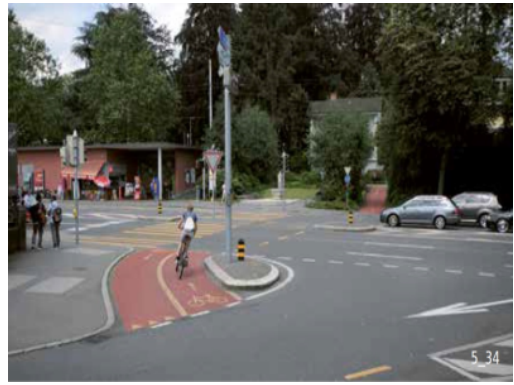
Gué vélo et piste cyclable séparée à Lucerne (source: OFROU et Conférence Vélo, 2022)
