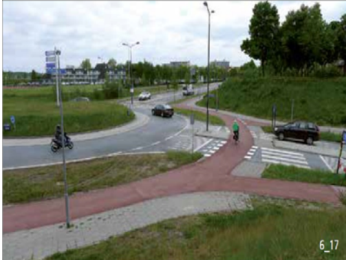
Getrennter Radweg mit Vortritt bei den Kreiselleinfahrten in den Niederlanden. Quelle: ASTRA & Velokonferenz Schweiz, 2021
