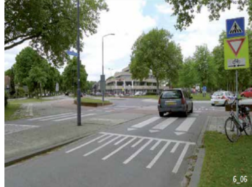
Vertikaler Absatz, mit dem die Geschwindigkeit der Autofahrenden bei der Einfahrt in den Kreisel reduziert werden kann, Niederlande. Quelle: ASTRA & Velokonferenz Schweiz, 2021
