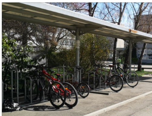
Parking vélo couvert sur le site du Centre professionnel du nord vaudois (CPNV) à Yverdon-les-Bains
