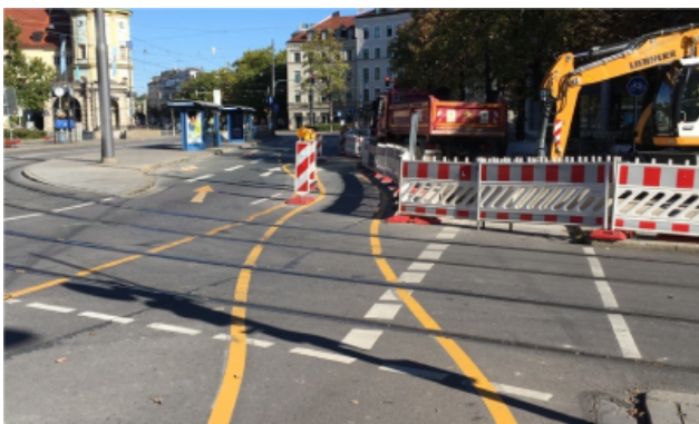
Bei einer Strassenbaustelle am Stiglmaierplatz in München wird ein temporärer Radweg eingerichtet, der deutlich auf dem Boden markiert und mit temporären Einrichtungen vom MIV abgetrennt wird.
