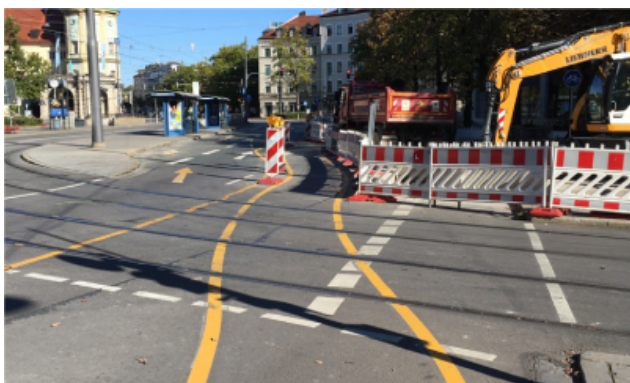
Lors d'un chantier routier à Stiglmaierplatz à Munich, une piste cyclable temporaire est aménagée, marquée clairement au sol et séparée avec des aménagements temporaires du trafic motorisé
