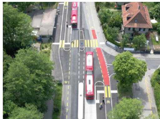
Bypass an der Bushaltestelle Dübystrasse, Bern
