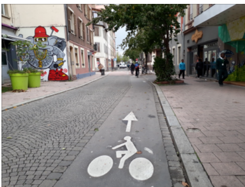
Geteerter Radstreifen auf einer gepflasterten Strasse, Strassburg
