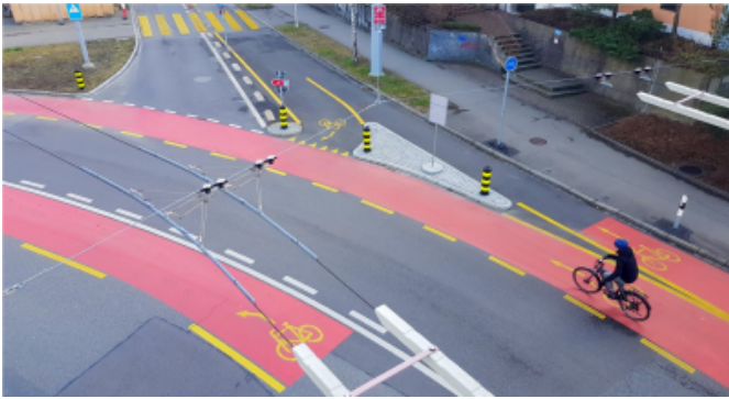
Roter Strassenbelag auf dem Bucheggplatz, Zürich
